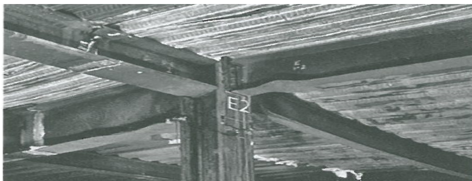
Σχήμα 9: Όψη της κατασκευής μετά από το πείραμα 3 [6]
