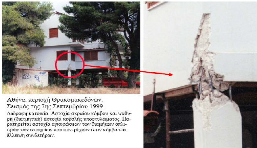
Εικόνα 2: Αστοχία αγκύρωσης των διαμήκων ράβδων. [3]
