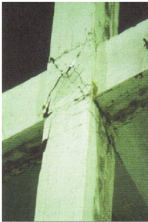
Εικόνα 4: Χιαστί κολλάρα [4]
