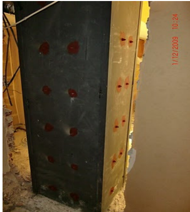
Εικόνα 3: Ενίσχυση υποστυλώματος με μεταλλικό μανδύα [7]
