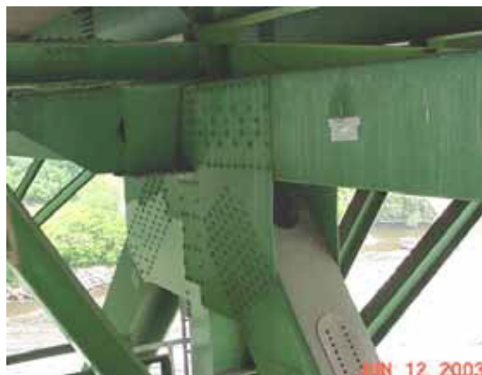
Σχήμα 9: Λυγισμός κομβοελασμάτων του φορέα U10[12]
