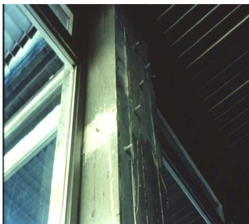
Σχήμα 4: Ρητινένεση
