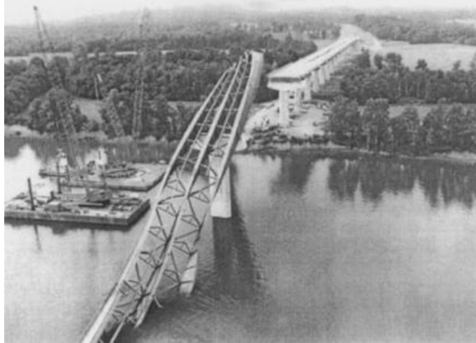
Σχήμα 5: Φωτογραφία από την κατάρρευση της γέφυρας στον ποταμό Tennessee[8]
