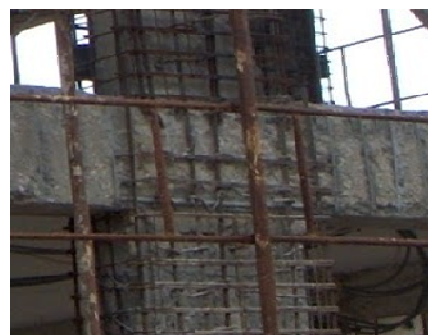
Εικόνα 3: Μανδύας οπλισμένου σκυροδέματος [9]
